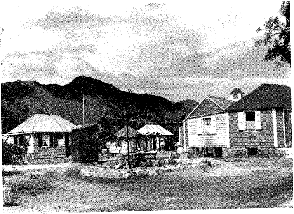
Fig. 15. Groep huizen der blanke visschers aan de Simpsonbaai te St. Maarten, met een gemeenschappelijk privaat, als maatregel tegen de mijnworminfectie.
